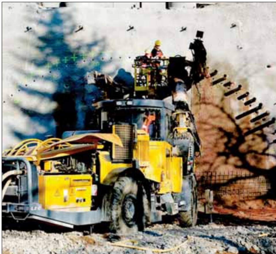
Ein Bohrwagen treibt am künftigen Tunneleingang erste Löcher ins Gestein. Foto: Alex
